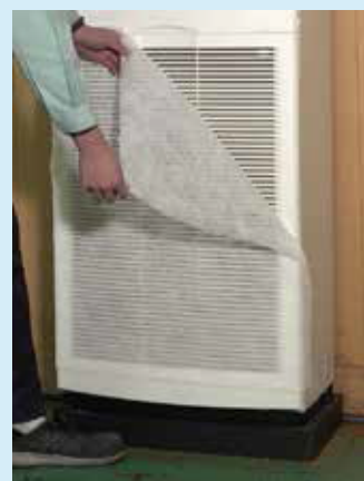
工場エアコンへの A800 取付例
