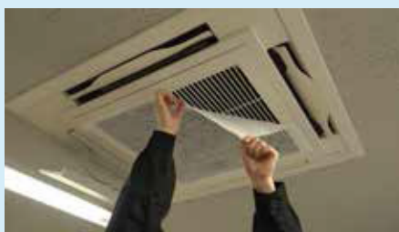
天井エアコンへの A600 取付例
